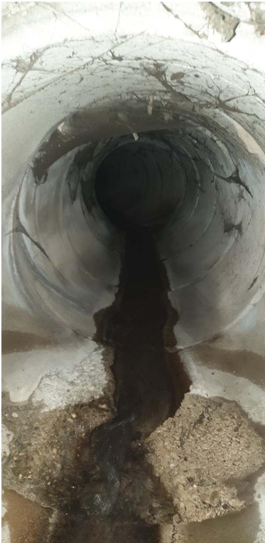
Imbocco da monte della condotta in cemento diam. 120 cm.
