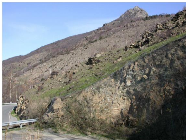
Settore in deformazione a monte della Provinciale
