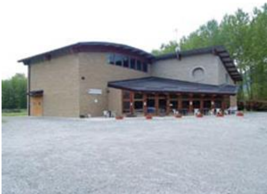
Il centro polifunzionale "La Sosta" che costituisce assieme alle altre aree di emergenza il "polo" più importante da utilizzare in caso di emergenza
