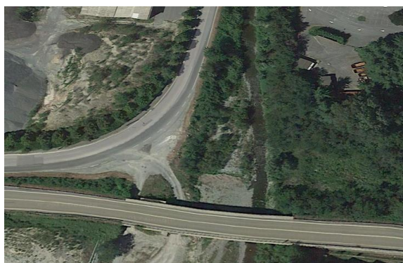
Il ponte della S.P. 24 sul Sessi (foto satellitare Google)
